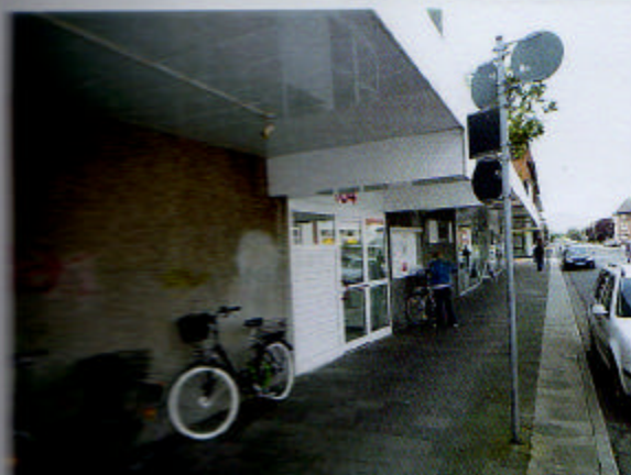
Eingang zentrales Treppenhaus
