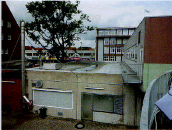
Rückseite und Dach Waschsalon
